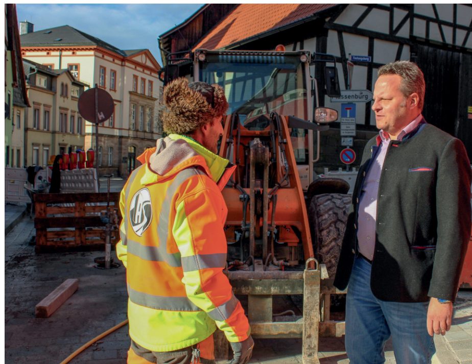
Oberbürgermeister Ingo Lehmann informiert sich auf der Kirchwehr-Baustelle über den Fortgang der Arbeiten.
