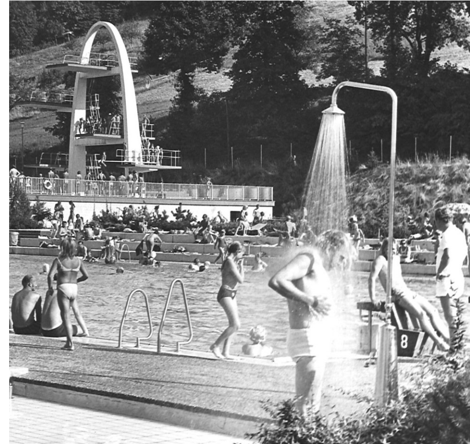
War schon immer ein Besuchermagnet – das Kulmbacher Freibad in den 70er Jahren. Jetzt müssen die Technik und das Schwimmerbecken saniert werden. Der beliebte „Affenfelsen“ (im Hintergrund) bleibt erhalten.
